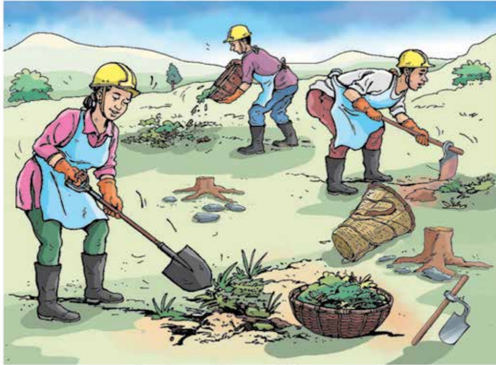
भवन निर्माण अघि स्थलको सरसफाई
